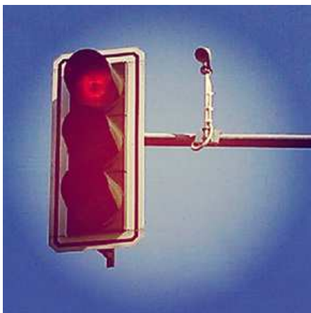
Slika 1: Postavitev video detekcijske kamere na semaforke bič
