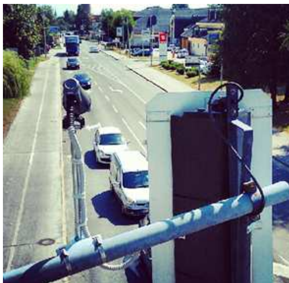
Slika 2: Postavitev video detekcijske kamere na semaforke bič
